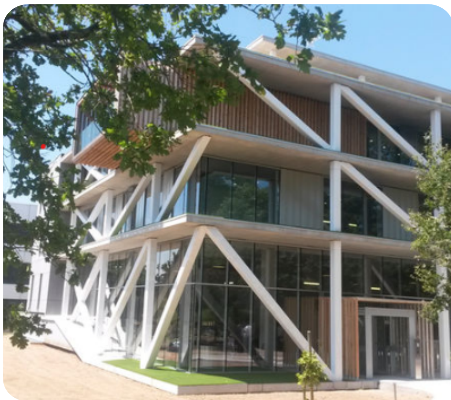
Notre bâtiment et son entrée pour nous trouver !
